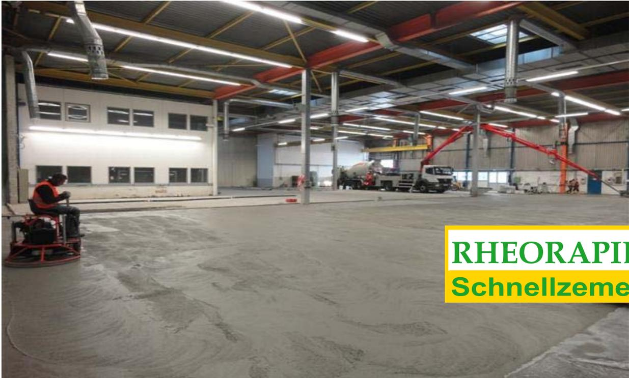
Monobeton aus RHEORAPID® Schnellzement erhärtet schnell und erreicht hohe Frühfestigkeiten. RHEORAPID®-Beton erhärtet praktisch schwindfrei und formstabil ohne störende Randaufwölbungen. RHEORAPID®-Beton ist wasserfest und geeignet für Dauernassbereiche. RHEORAPID®-Beton trocknet durch vollständige Hydratation und kann bereits nach wenigen Tagen beschichtet werden.
